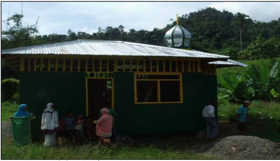
La construction de la mosquée
